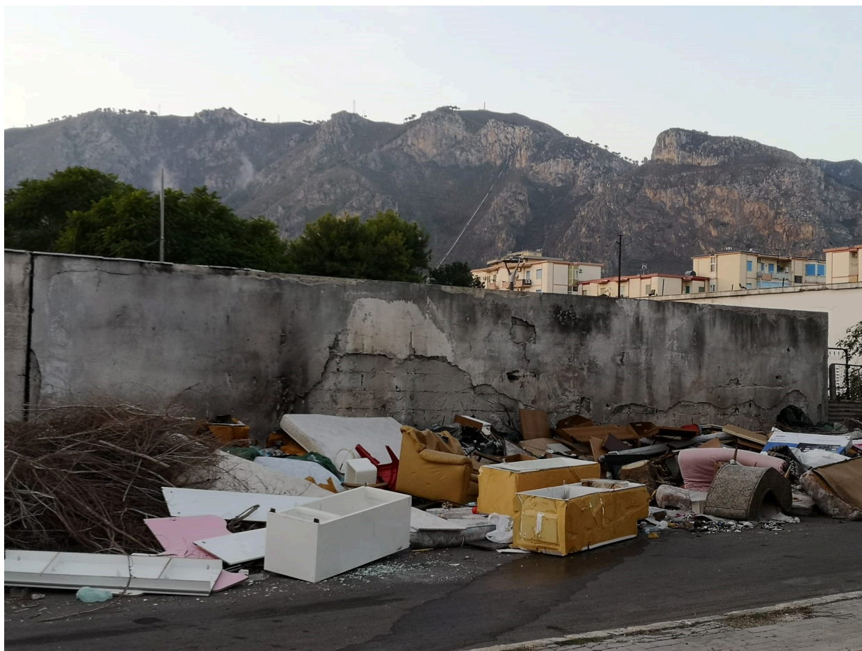
Il muro prima dell'intervento
